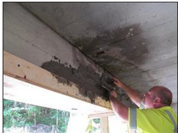
(d) Wood framework and repair mortar application
