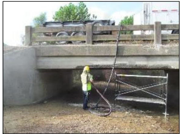
(b) Sandblasting rebar
