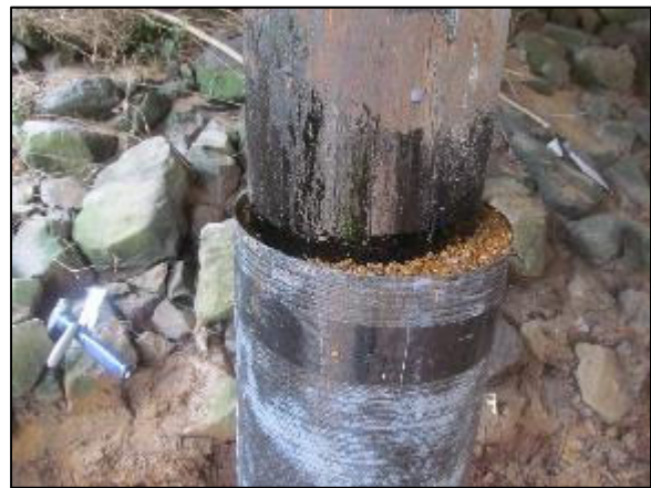
(d) Filling space with epoxy mortar
