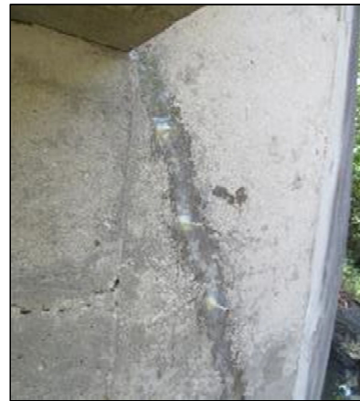
(d) Repair of abutment crack
