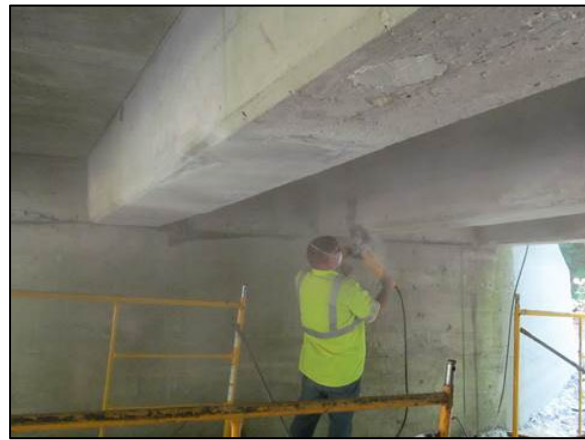
(d) Grinding excess repair mortar
