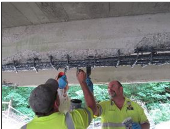
(c) Zinc primer brushed onto rebar
