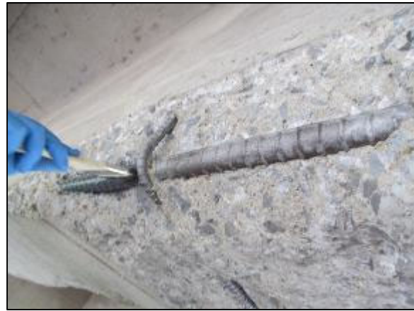
(b) Zinc primer brushed onto rebar
