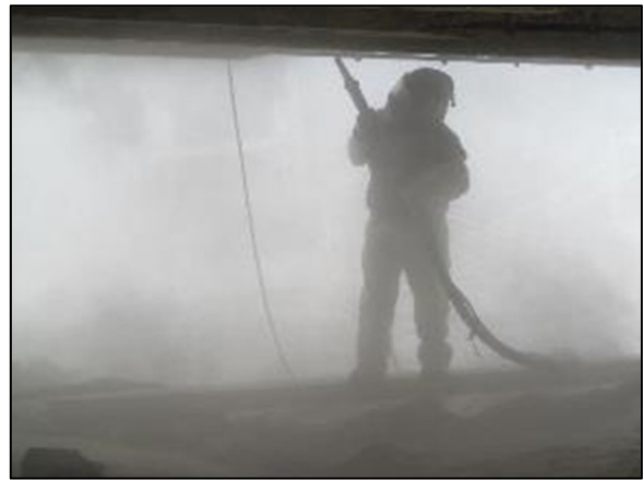
(b) Sandblasting rebar
