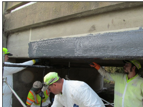
(d) Applied coat of epoxy over CatStrong fabric
