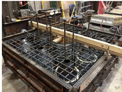
Figure 5.12. Pile cap before concrete pour
