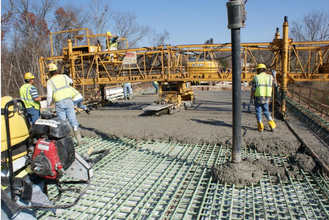
Figure 21. Deck pour on Beaver Creek Bridge.
