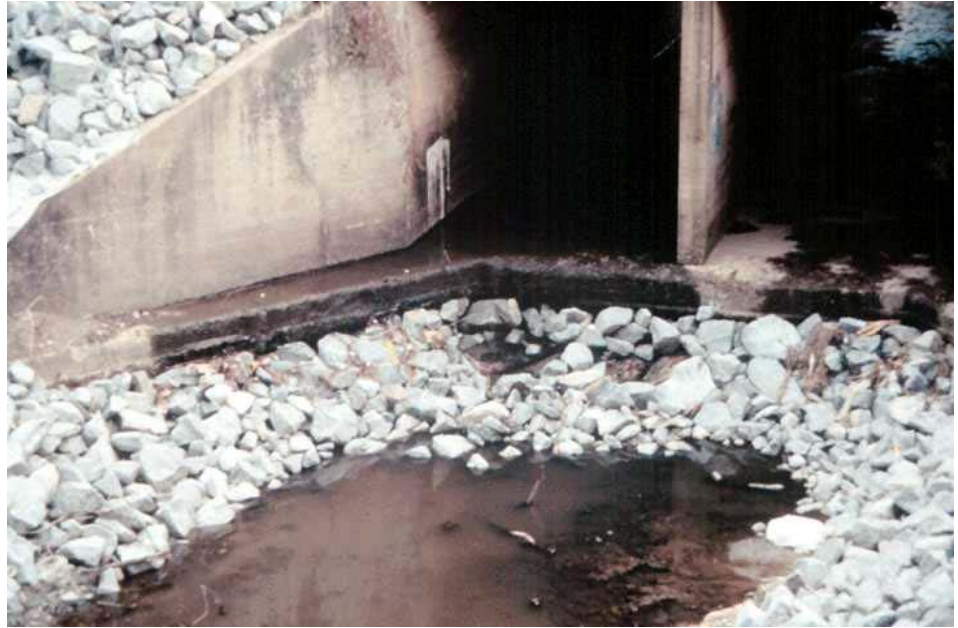
Figure P.3.19 Apron
