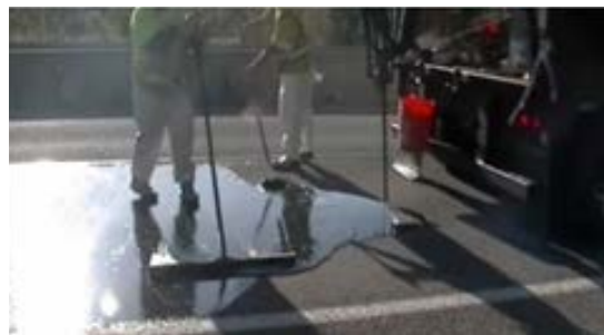
Figure 7. Semi-Automated Binder Pour Spigot.
