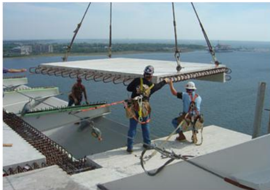
(d) Placement of a precast concrete deck panel
