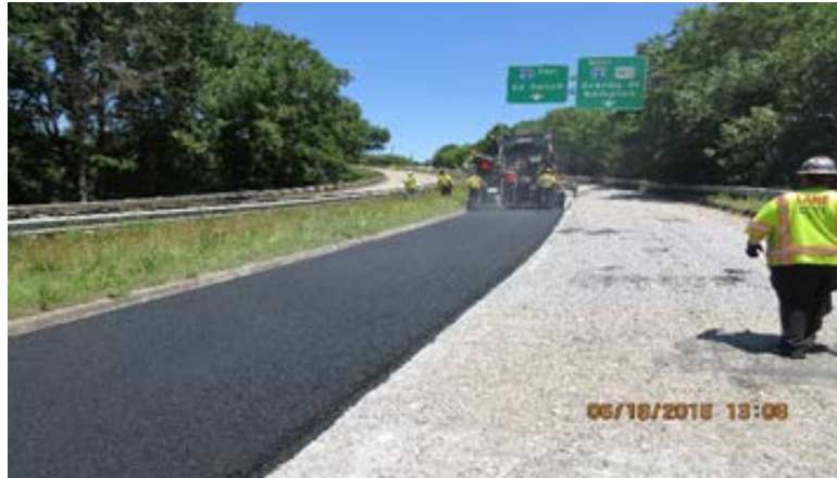
Figure 12. Placement of IM 19.0E Mixture
