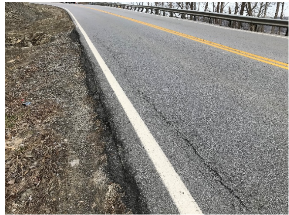
Figure 24. Longitudinal Cracking
