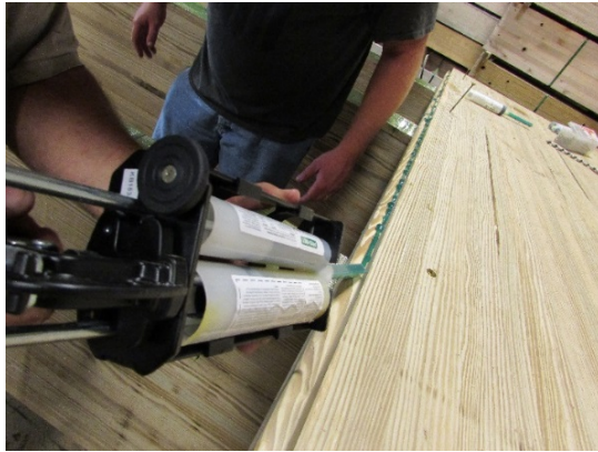
(d) Placing Epoxy in Deck-to-Deck Connection
