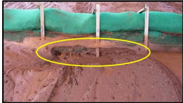
(d) undermining – pyramid installation
