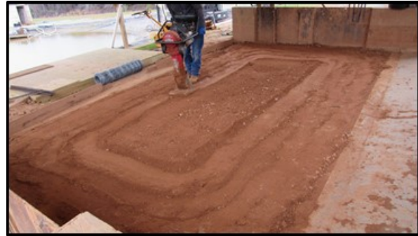
(d) jumping jack compaction plate
