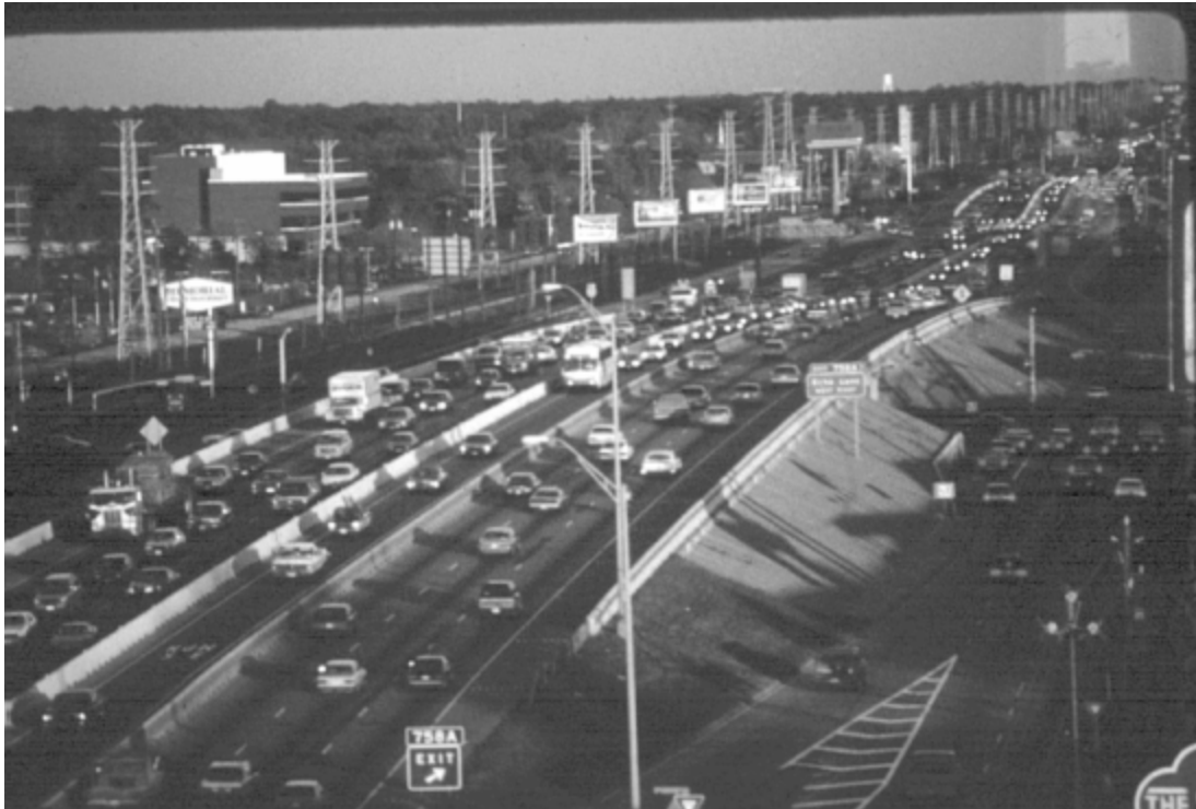
Figure 3-6. I-10 (Katy Freeway) HOV Lane in Houston, Texas.
