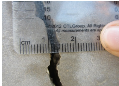
(d) Control maximum crack width measurement
