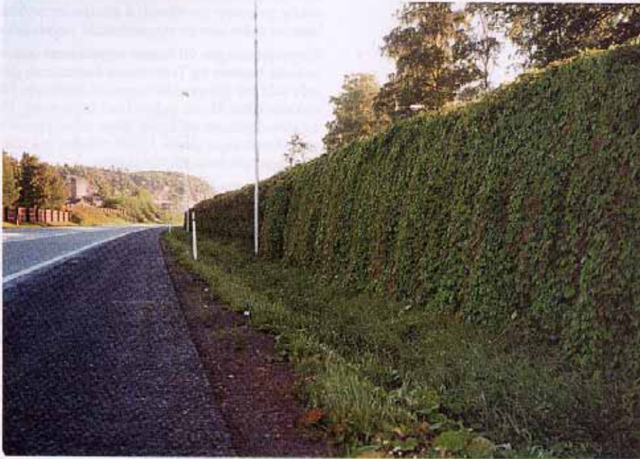
Fra E-18 i Stokke kommune i Vestfold Betongskjermer
