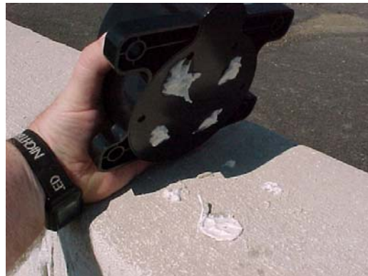
Fig. 25a EL Lamp Installation
