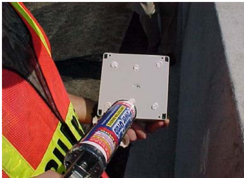
Fig. 25a EL Lamp Installation
