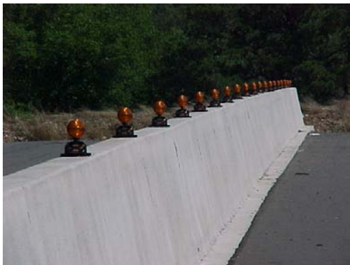
Fig. 25a EL Lamp Installation
