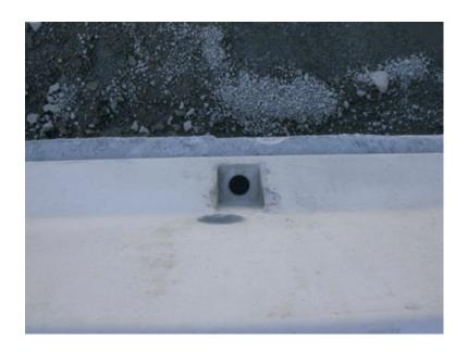
Figure 10. Barrier Tie-Down System
