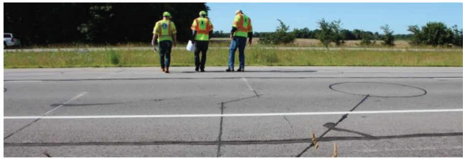
(d) WIM station #952100 pavement and sensor conditions
