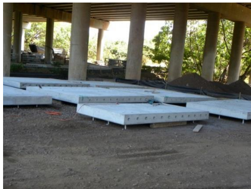
(d) Panel storage under the flyover
