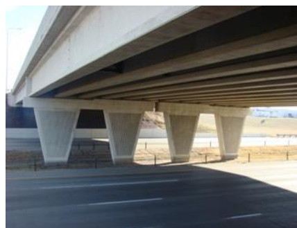
(d) Flared-Column Bent
