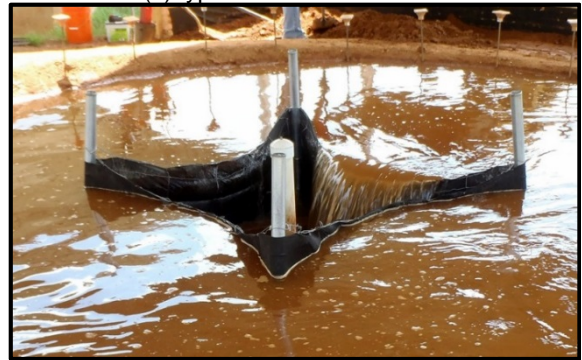
(d) fence post installation
