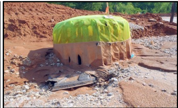
(d) manufactured device dislodgement
