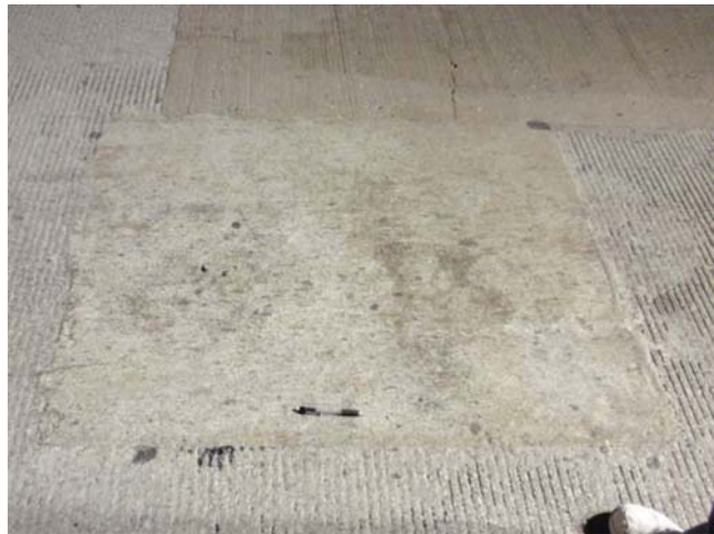
Figure D.12 MG-Krete patch-I.
