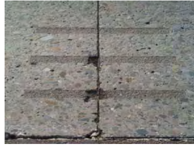
b. Spalling
