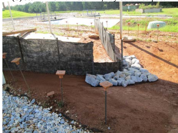
(d) TDOT enhanced install. w/rip rap dissipater
