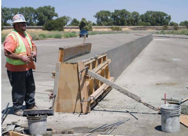
Figure 2-8 End Anchorage Pour Complete
