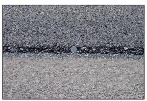
(d) Fracture-tolerant interlayer system (www.midlandasphalt.com)
