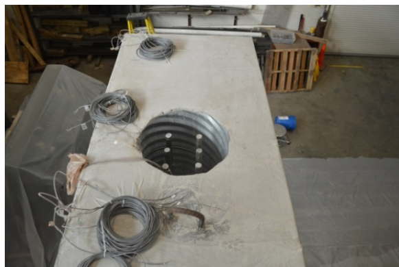
(d) Pocket Connection prior to Casting Concrete
