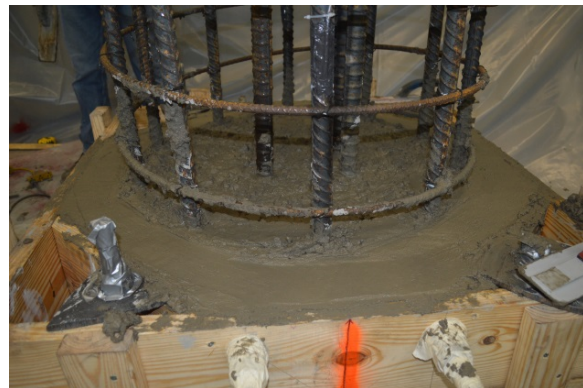
(d) Concrete Finish
