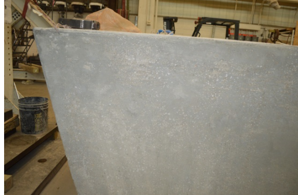
(d) Battered End - Repairs
