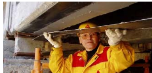
(d) CFRP plate flexural reinforcement of slab
