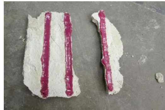
(d) Debonded section of mortar
