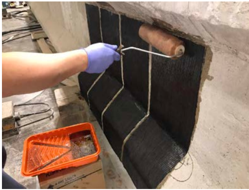
(d) Saturating laminates with resin
