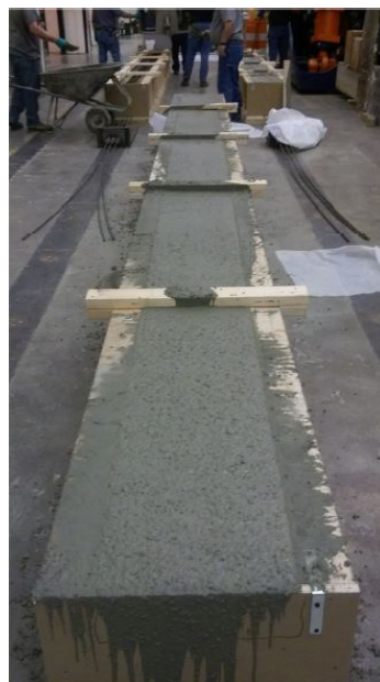
(d) Completed pouring
