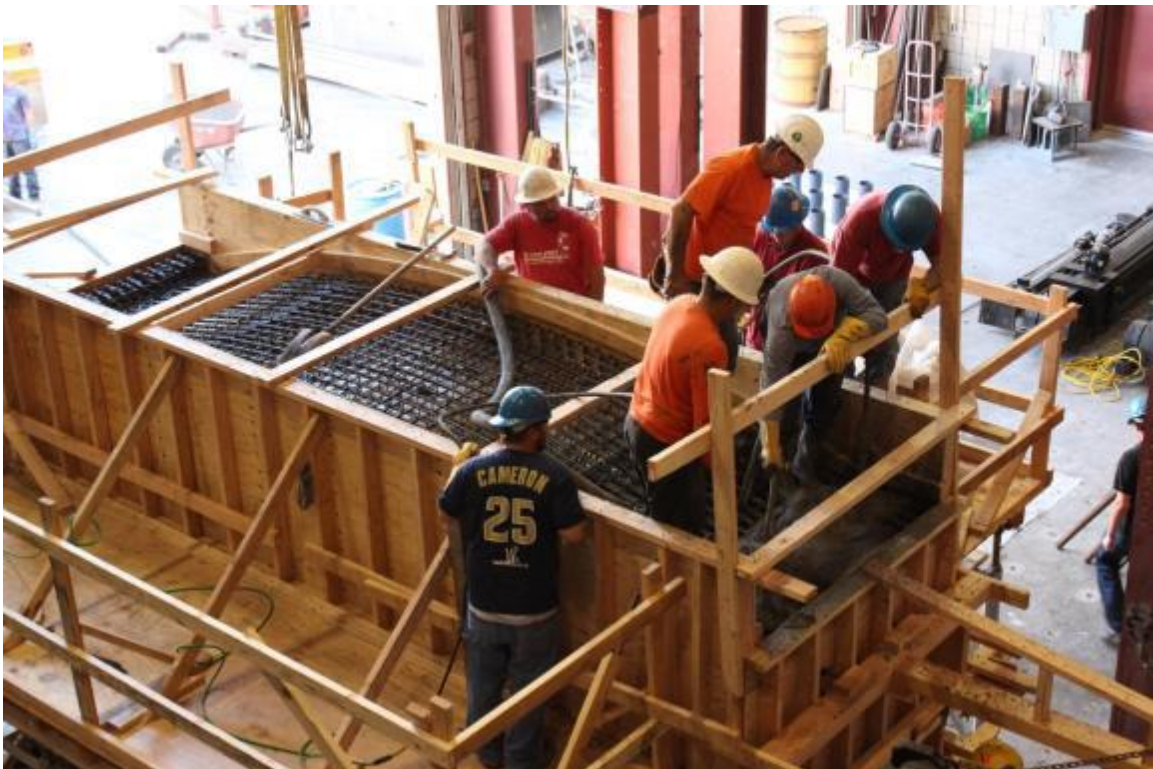
Figure C-9: Concrete pour for the wall
