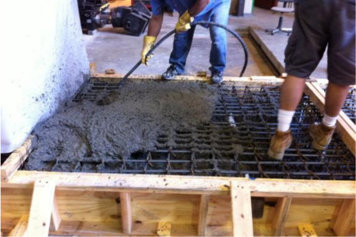
Figure C-4: Concrete pour for the slab
