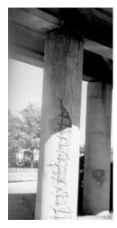
(d) Column Corrosion
