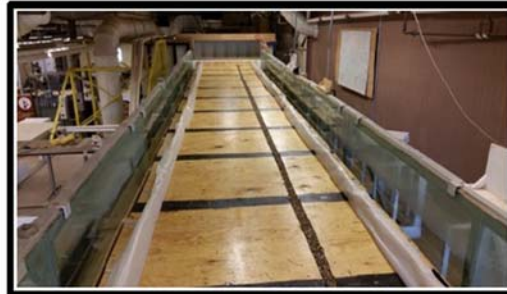
a) Side Walls for PFC Pour
