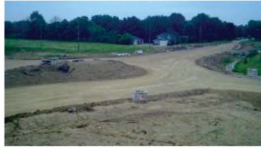
(d) 7/16/15 – Drainage structures
