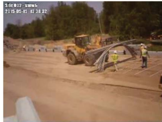
(d) Placing reinforcement straps
