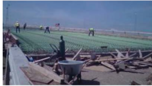
(d) 6/24/15 – Steel is placed on bridge
