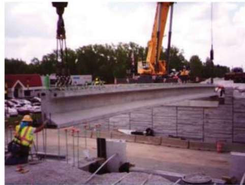
(d) Place concrete bridge beams 6/5/15
