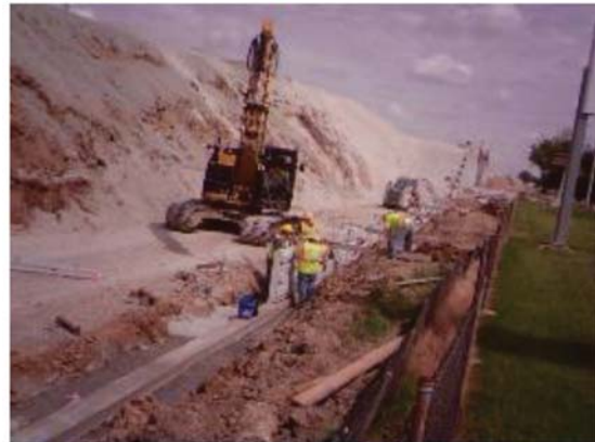
(d) Place temporary wood panel supports
