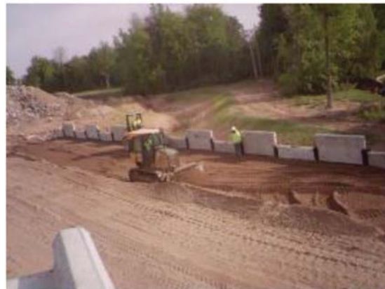
(d) Compaction begins, lift is complete
