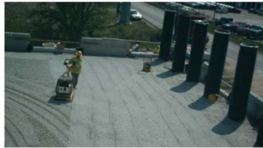
(d) 11:45 AM – Soil compaction
