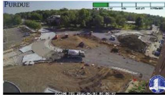
(d) Form up and place concrete pavement 6/7/16
