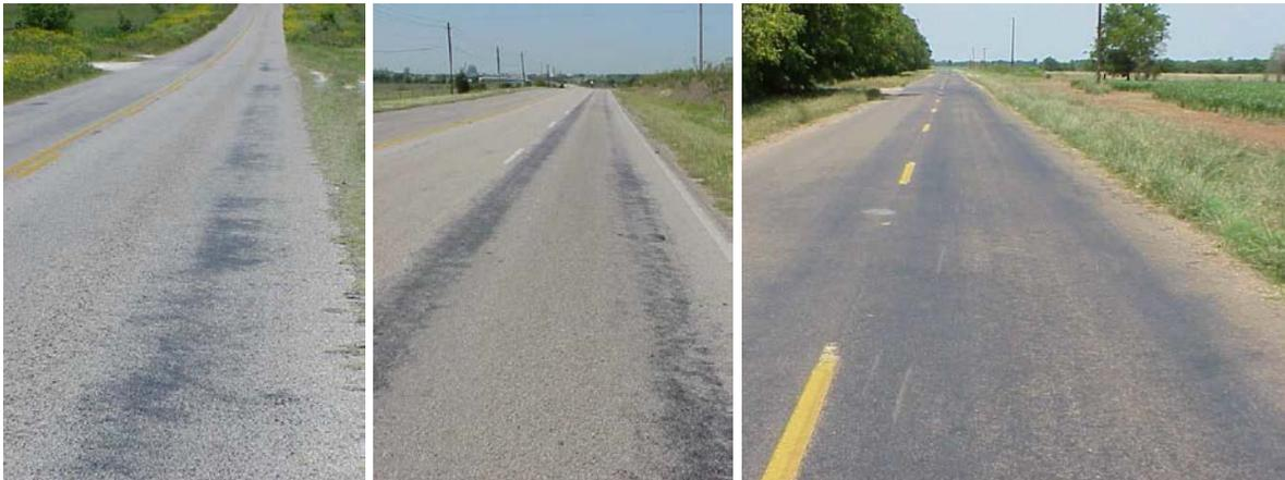
**Figure B-8. Bleeding (Flushing).**
