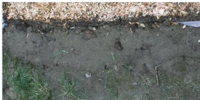
(d) Soil backfilling
