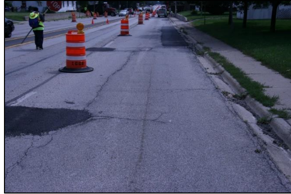
Longitudinal Cracking
