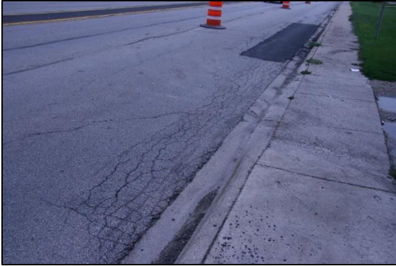
Edge Cracking
