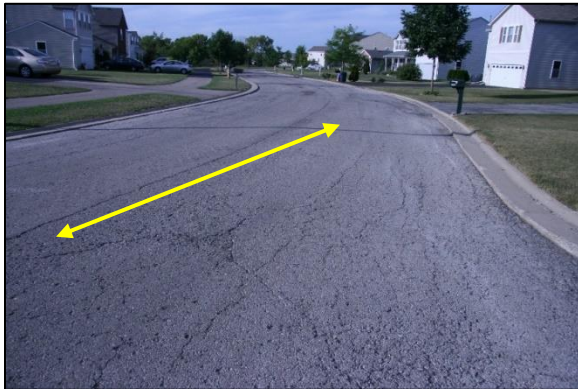
Longitudinal Cracking
