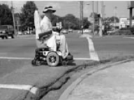
Uneven Ramp Slope
