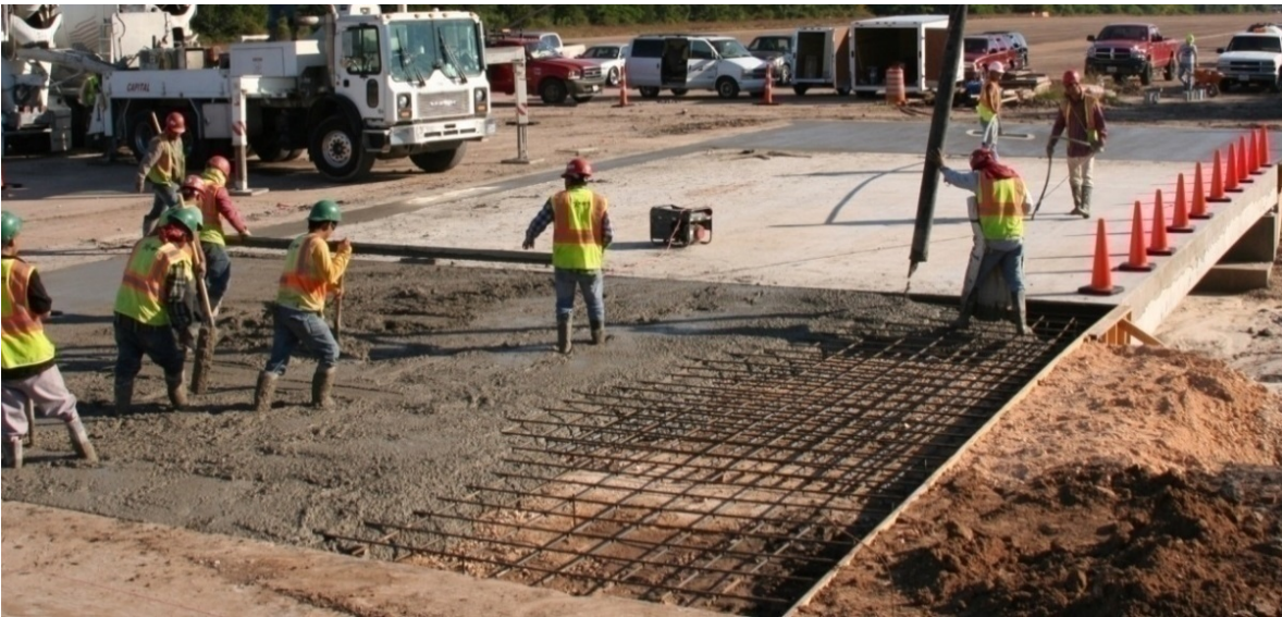
(c) Approach Slab Pour
