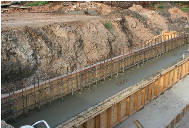
(d) Abutment Concrete Pour
