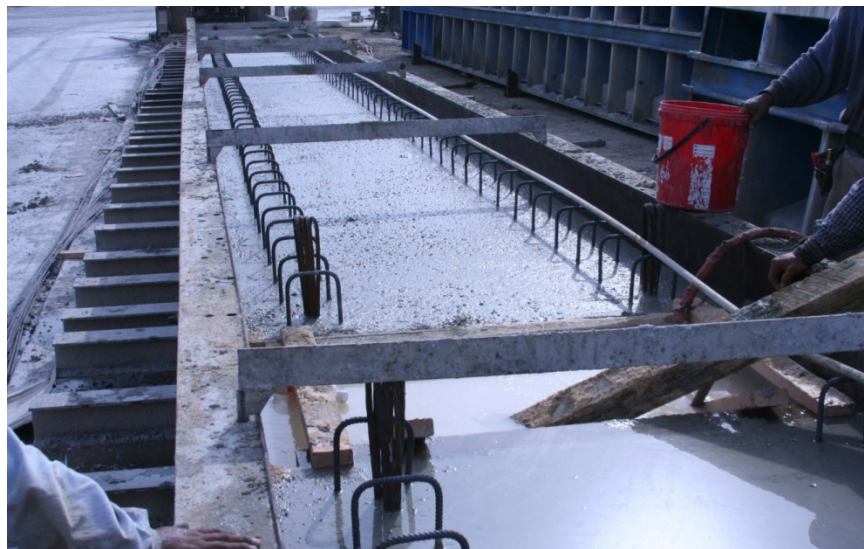
(c) Slab Beam Pour
