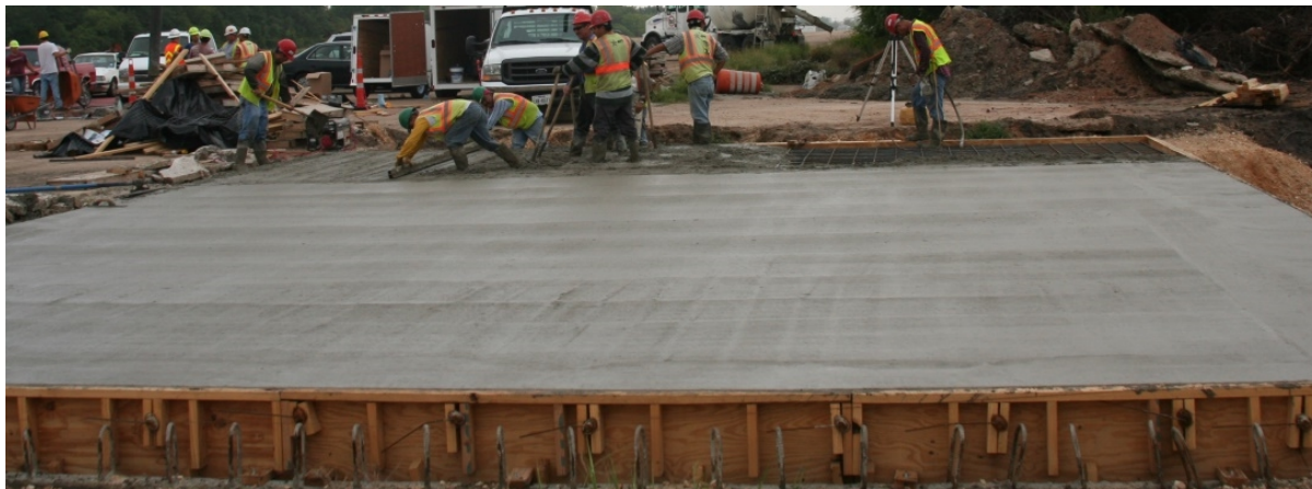
(c) Deck Concrete Pour
