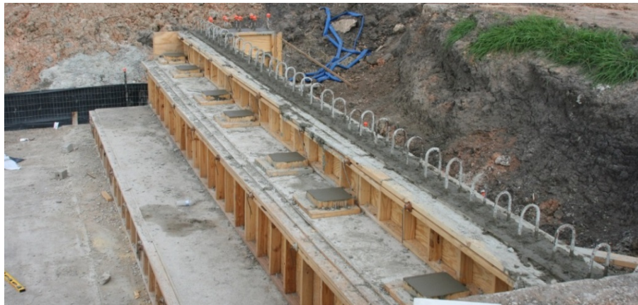
(a) Back-Wall, Pedestal, and Wing-Wall Pour
