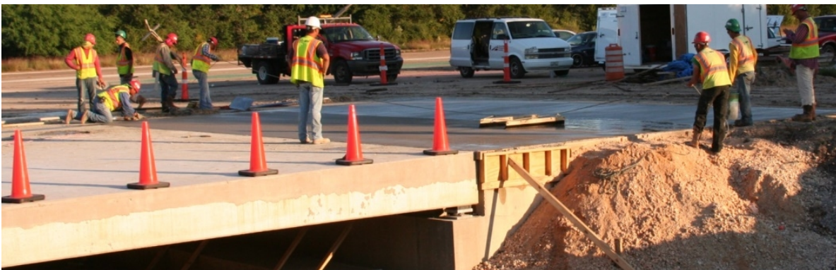
(d) Approach Slab Broom Finish
