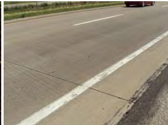
Longitudinal cracking
