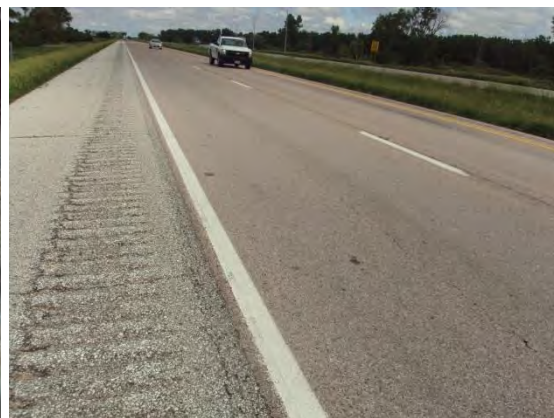
Longitudinal cracking
