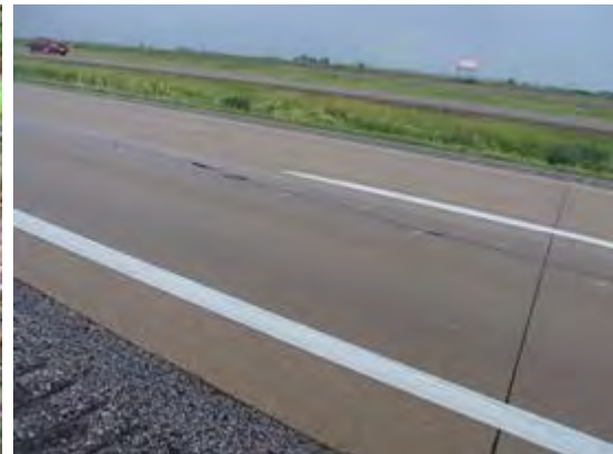
Longitudinal cracking
