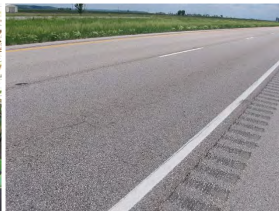
Longitudinal cracking
