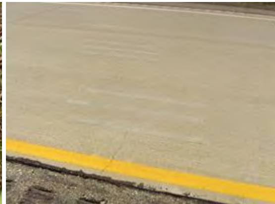
Dowel bar retrofit
