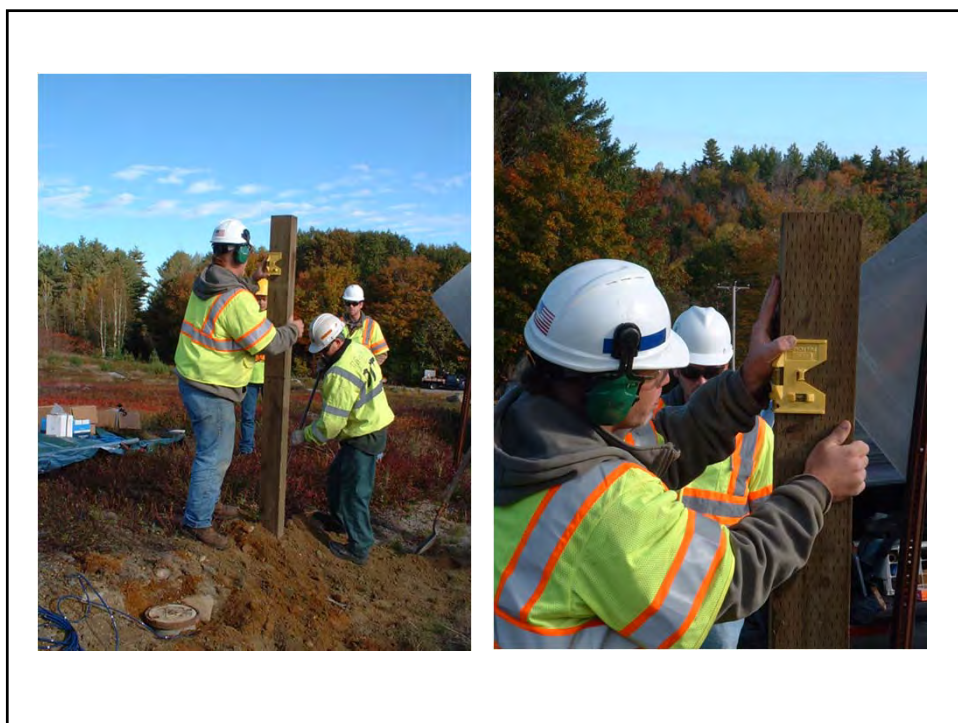
Fig E-8. Installing Readout Post
