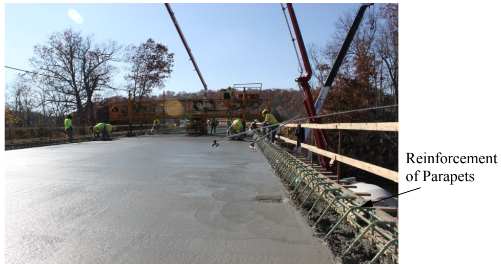
Figure 3-5 Pour of B0439 Deck
