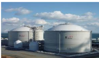
Figure 2(k). LNG Storage Tanks
