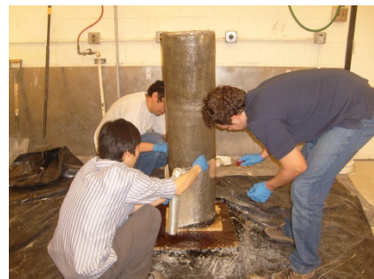
(e) FRP wrapping
