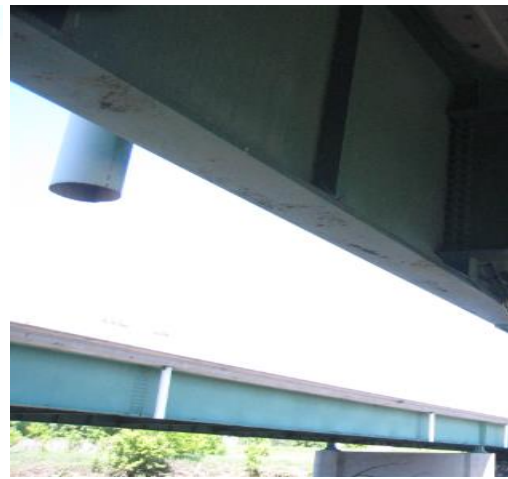
(d) North girder
