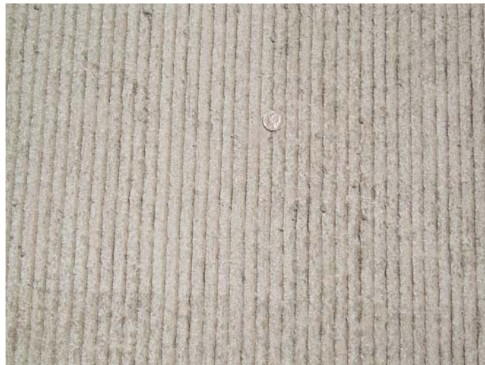
Figure 2.7. Longitudinal tining
