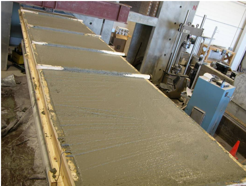
Figure 3.3.16: Pour Deck Concrete
