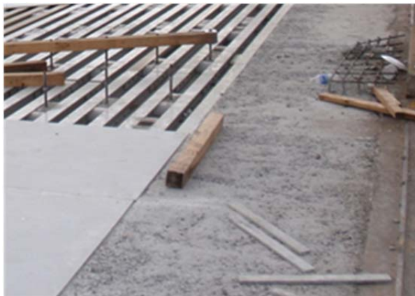
Figure 119 – Top plate free edge
