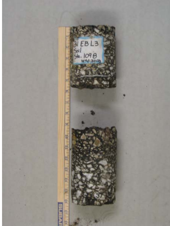
GDOT Core 31 (Lane 3)
