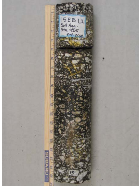
GDOT Core 15 (Lane 2)
