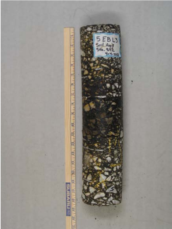
GDOT Core 2 (Lane 3)
