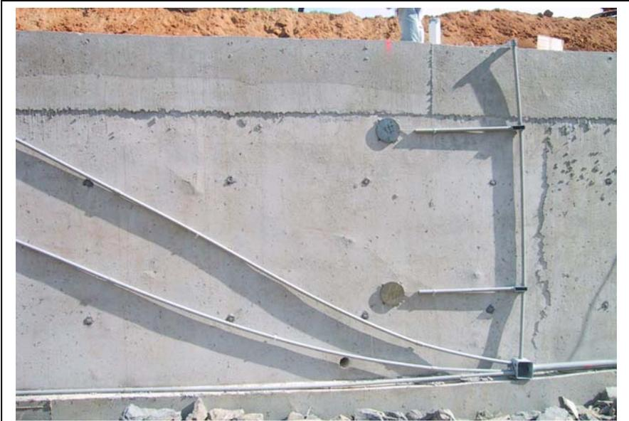
Figure 19. PVC conduits protect electric cables.
