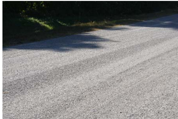
(d) Chip or Scrub Seal Completed-Hwy 17
