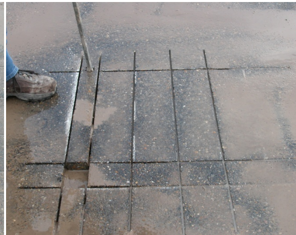
(d) Removal of Specimens
