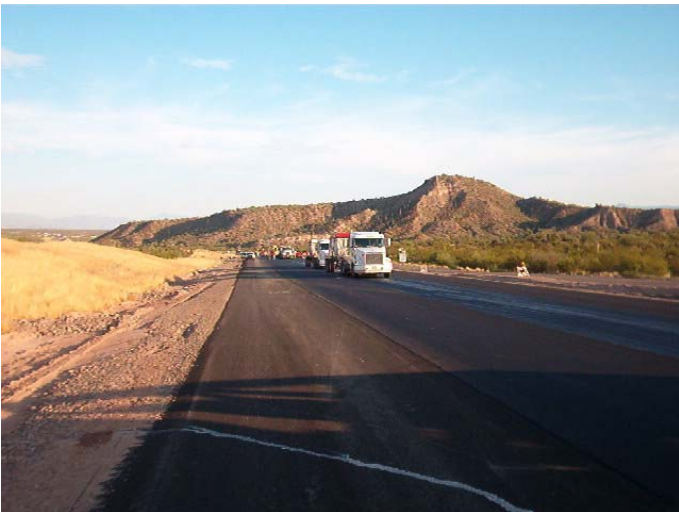
Figure N.17 – View of Site 6
