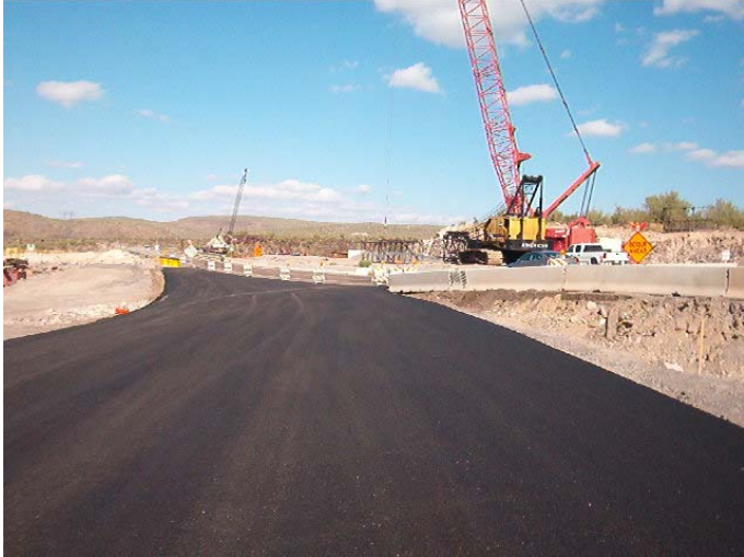
Figure N.12 – View of Site 4
