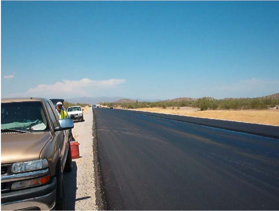
Figure N.1 – View of Site 1
