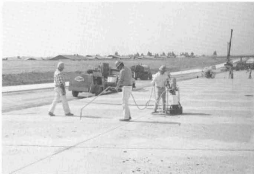
FIGURE 18- PLACING G. E. SILICONE
